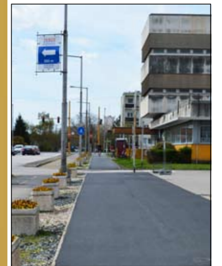
Erkel utca – járdafelújítás (2024)
