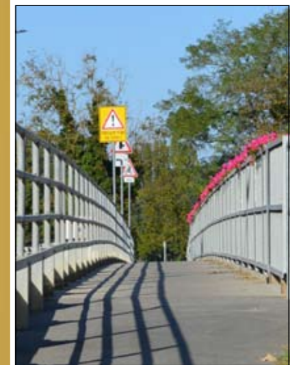
Kerékpárút a Lajta-hídon
