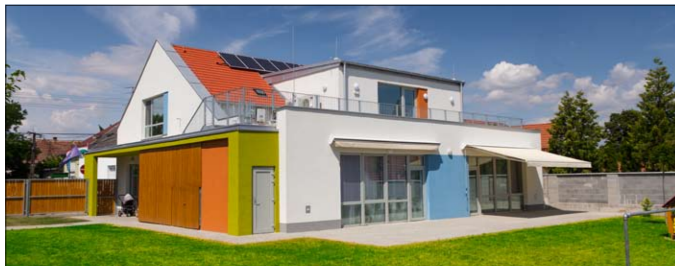
A Margaréta Bölcsőde (2019) korszerű épülete
